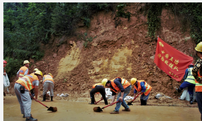
中国五冶处置道路山体滑坡及道路保通
