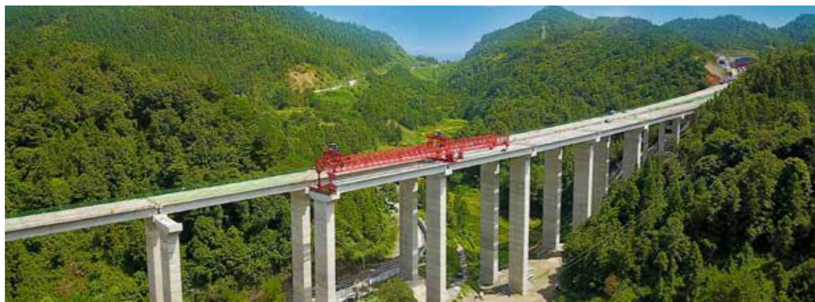
贵州三荔高速公路项目水龙大桥
