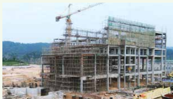
关丹联合钢铁项目采用了一系列由中国中冶研发的核心技术和装备，图为正在建设中的烧结冷却室，采用了烧结机综合密封技术、发电式环冷机及成套装备
