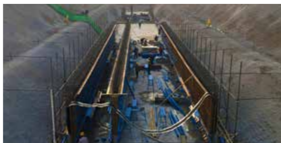
吉林省哈达湾区域地下综合管廊南北干线建设工程项目
