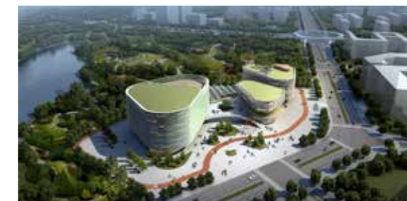
宝龙湖体育运动公园建设及宝龙片区道路提升改造项目
