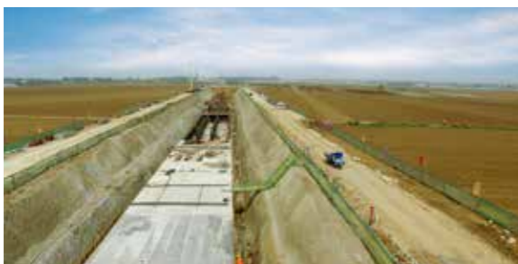
吉林省四平市四梨同城化地下综合管廊项目
